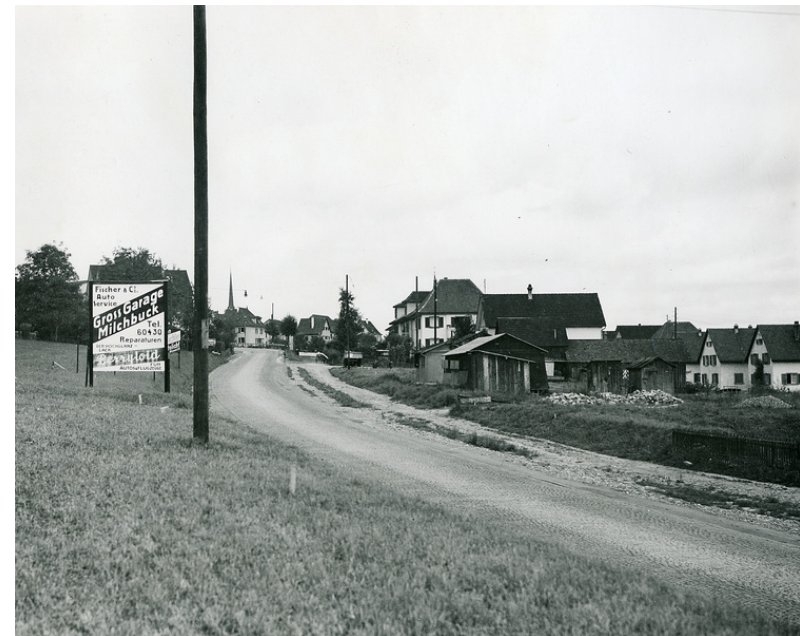
1936: Die Ueberlandstrasse vor ihrem Neubau (Bild: BAZ_134245)
