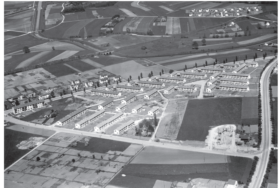
Genossenschaft auf freiem Feld: Die Siedlung im Dreispitz 1945 (Bild: BAZ_132477, Swissair)
