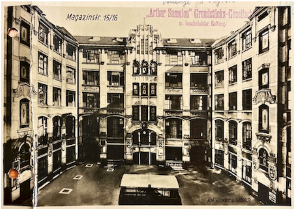
Ansicht des Gebäudes der Firma Arthur Samulon in der Magazinstraße 15/16, Berlin, nach 1912 376
