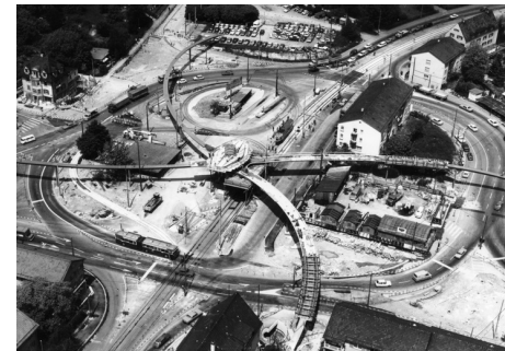
1970: Bucheggplatz und Fussgängerüberführung im Bau (Bild: BAZ_146466, Comet)
