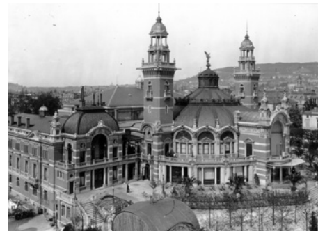
Abbruch 1937: Der alte Tonnalle-Pavillon (Foto: BAZ_054582, Ludwig Macher)
