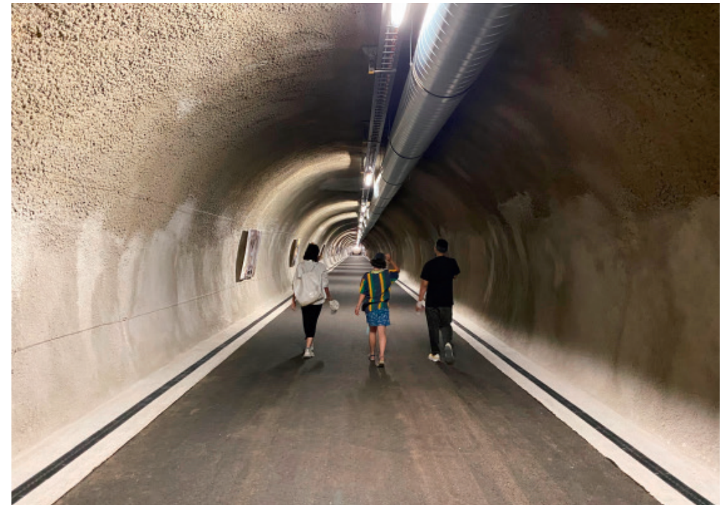
Werkführung im Seewasserwerk Moos. Besichtigung des Ringstollens in der Kaverne – Stollenabgang Richtung der Reservoirs Frauental und Lyren.
